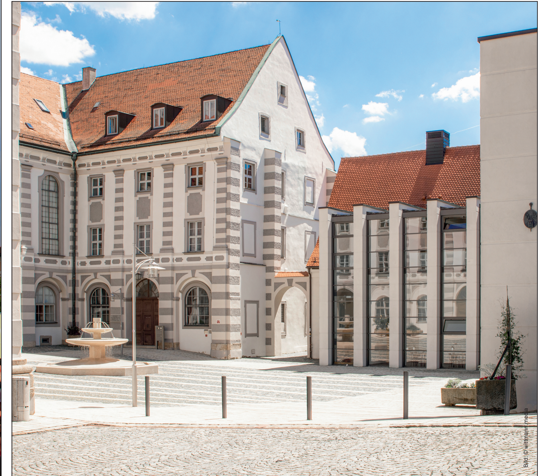
Generalsaniertes Kloster mit Gästehaus St. Joseph
