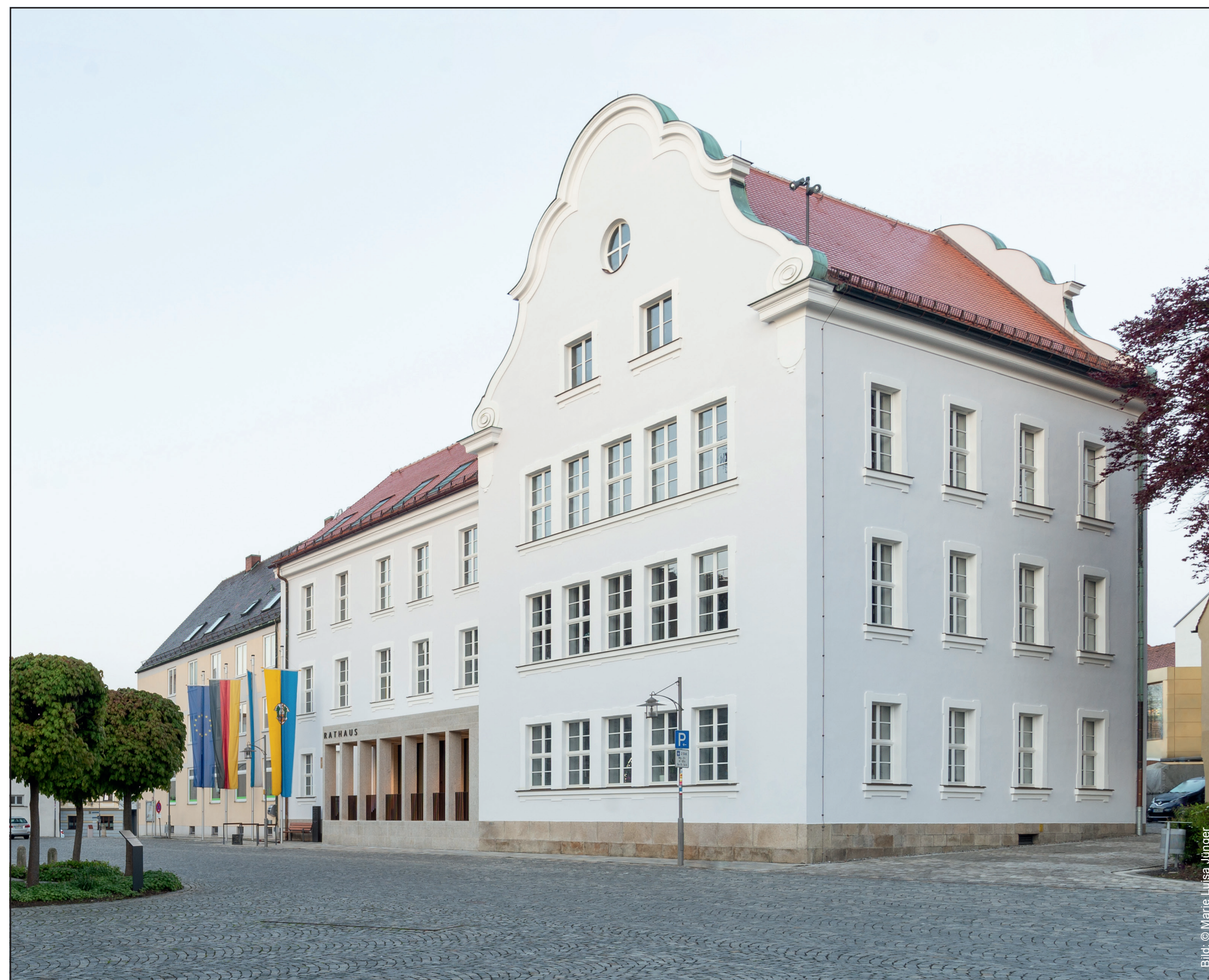
Saniertes Rathaus Waldsassen, Architekt Brückner & Brückner Tirschenreuth
